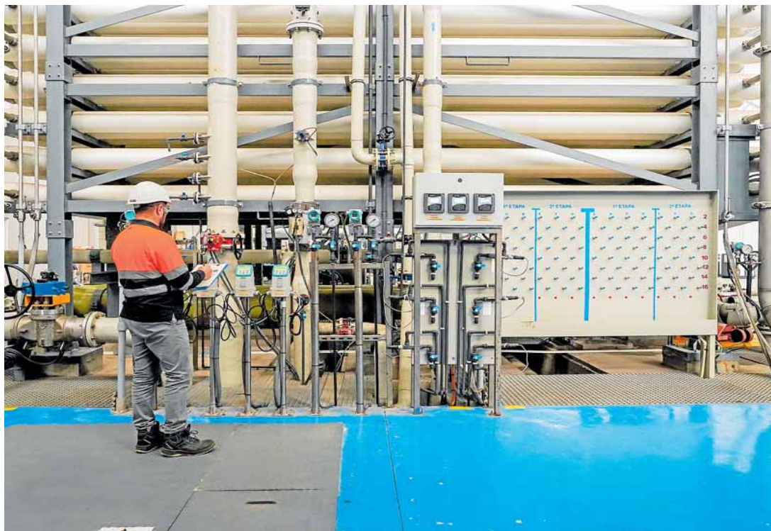
Imagen de archivo de una desaladora de agua de mar. SUR
